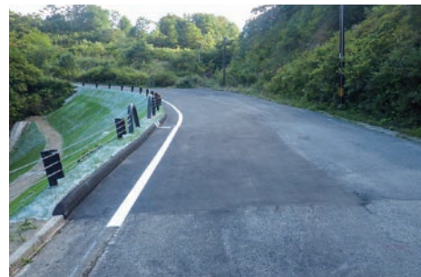
▲復旧後(令和3年10月)
