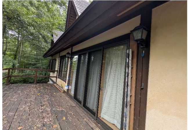
リビング側窓（交換後）※引き戸に変更
