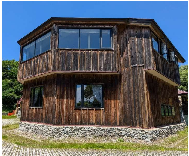
外観東側（建物：食堂・洋室）
