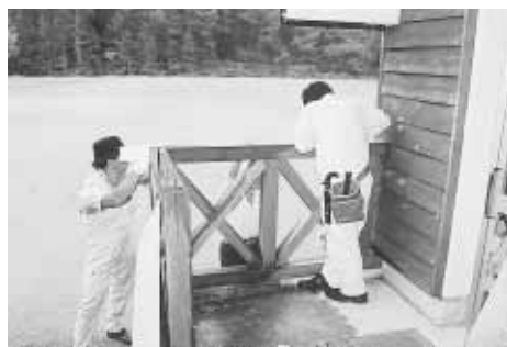
▲裏磐梯小・体育館南側外階段手すり修理
