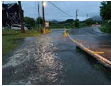
▲冠水する歩道(曾原地区)
