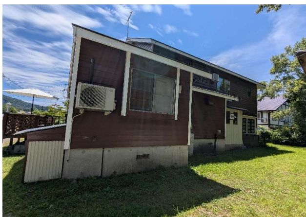
北西側外観（厨房・浴室など）
