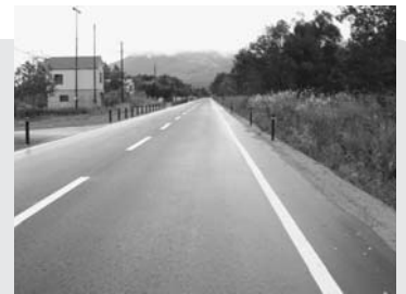
▲整備が進んだ村道剣ヶ峯・狐鷹森線
