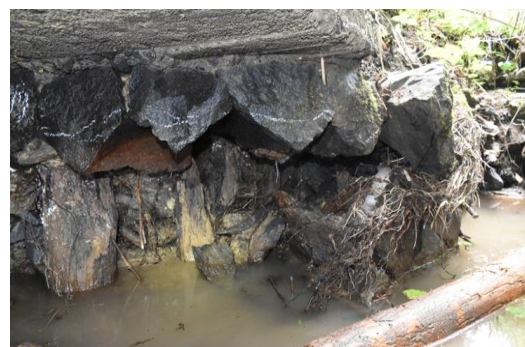
橋台石積の崩落
