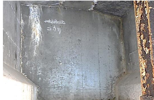
端横桁打継部の錆汁を伴った遊離石灰
