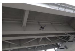
ドローンによる桁下の点検
