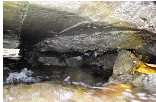
橋台石積の崩落
