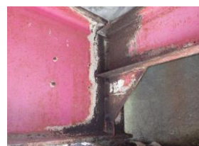
桁端部の腐食（Ⅲ）
