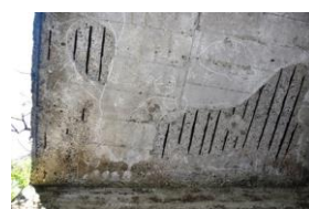
床版下面の鉄筋露出 及びうき（Ⅲ）
