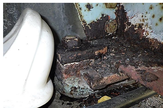
桁端部の腐食、支承部ナットのゆるみ
