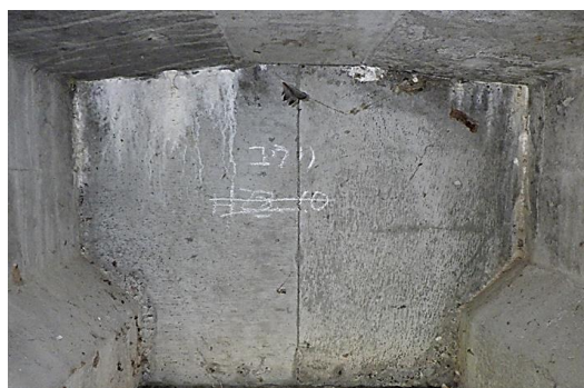
端横桁打継部の錆汁を伴った遊離石灰
