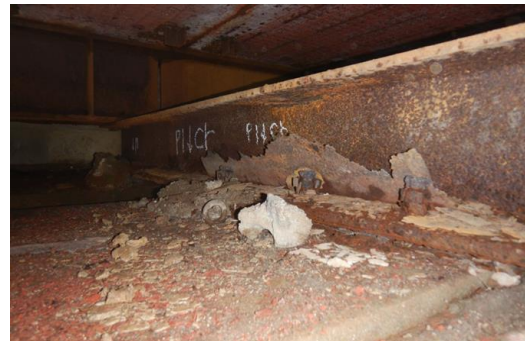
端横桁、支承部の腐食
