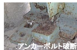
桁端部の腐食、支承部ナットのゆるみ
