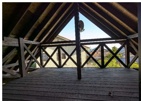
南側窓前デッキ部分
