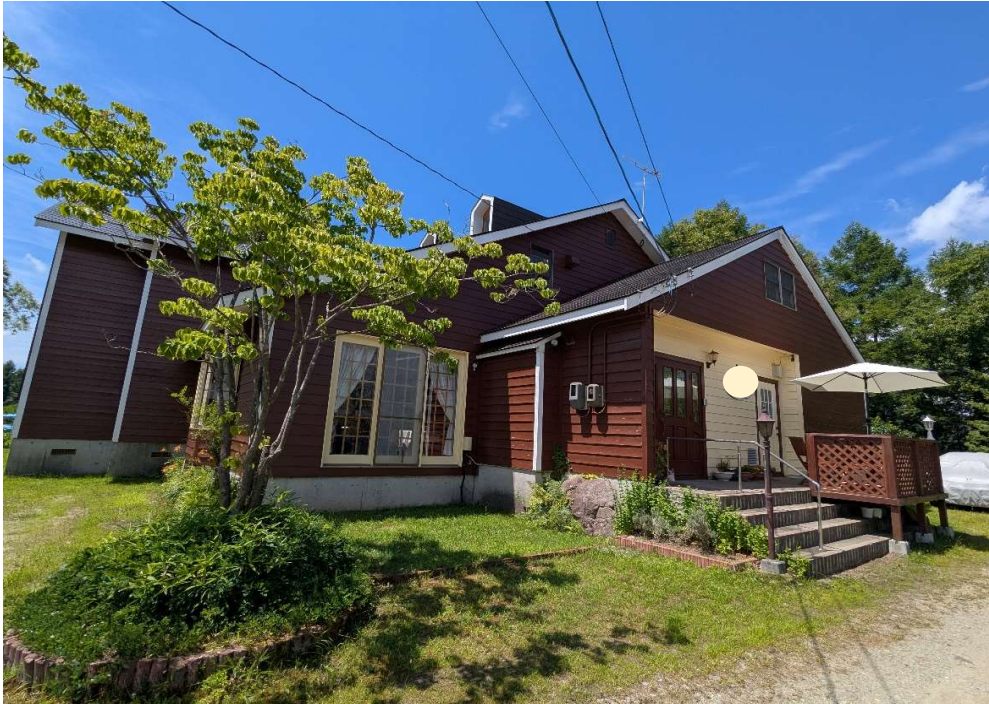
北東側外観（玄関・食堂）
