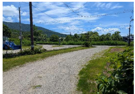
入口通路（敷地内・村道に接道）
