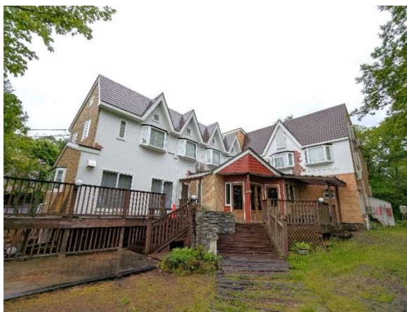
玄関付近外観
