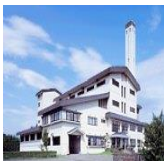
●山都工場焼却施設
