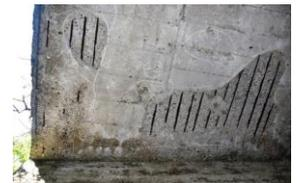
床版下面の鉄筋露出
