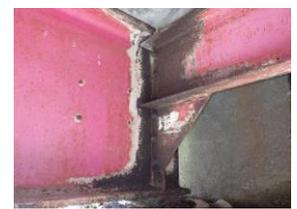
桁端部の腐食（Ⅲ）
