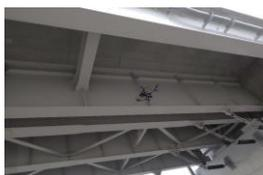
ドローンによる桁下の点検
