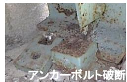
アンカーボルト破断
