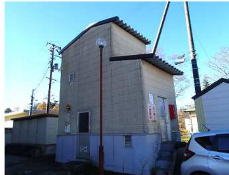
団地内状況（ポンベ室・ポンプ室）
