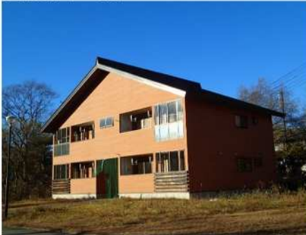
住棟近景（2号棟）
