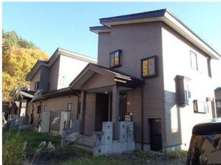
住棟近景（2号棟）
