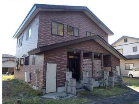
住棟近景（3号棟）
