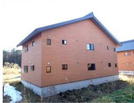
住棟近景（1号棟）
