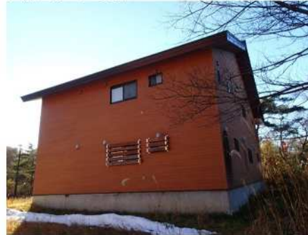
住棟近景（2号棟）
