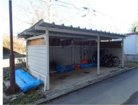
団地内状況（駐輪場）
