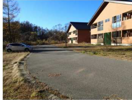
団地内状況（通路・駐車場）
