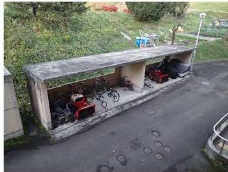
団地内状況（ポンペ庫）
