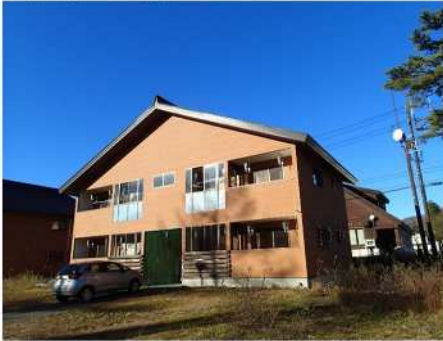
住棟近景（1号棟）
