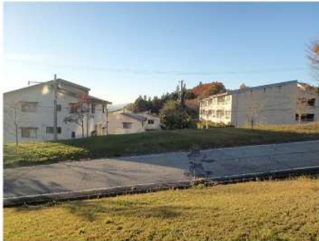
団地内状況（駐車場）
