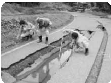
◀陥没した道路を調査する 渡部副技査（右端）
