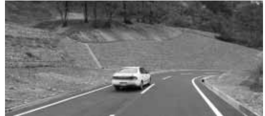
災害復旧工事により、円滑な交通が可能となった蘭峠(松原)
