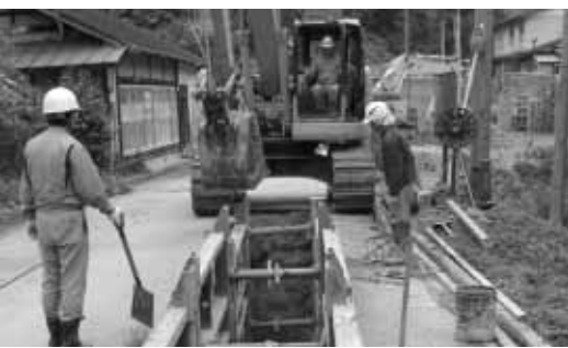
◀公共下水道工事が進む新田地区(大塩)
