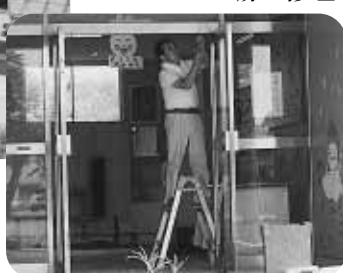
▼北山小学校 扉の修理
