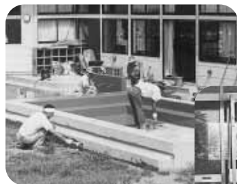
▲北山幼稚園 プールのペンキ塗り
