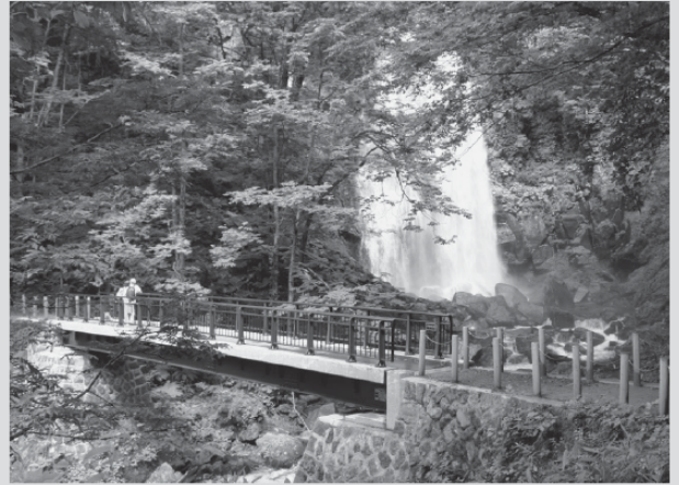
▲トロッコ道跡の歴史資源を活かして整備した「小野川不動滝遊歩道」の橋りょう
