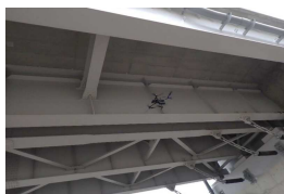
ドローンによる桁下の点検
