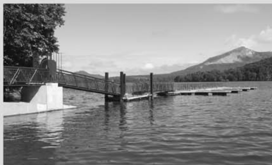
整備された長峯地区の栈橋▶
