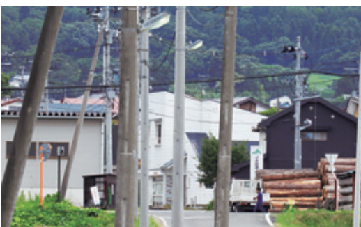
村内に設置の防犯灯
