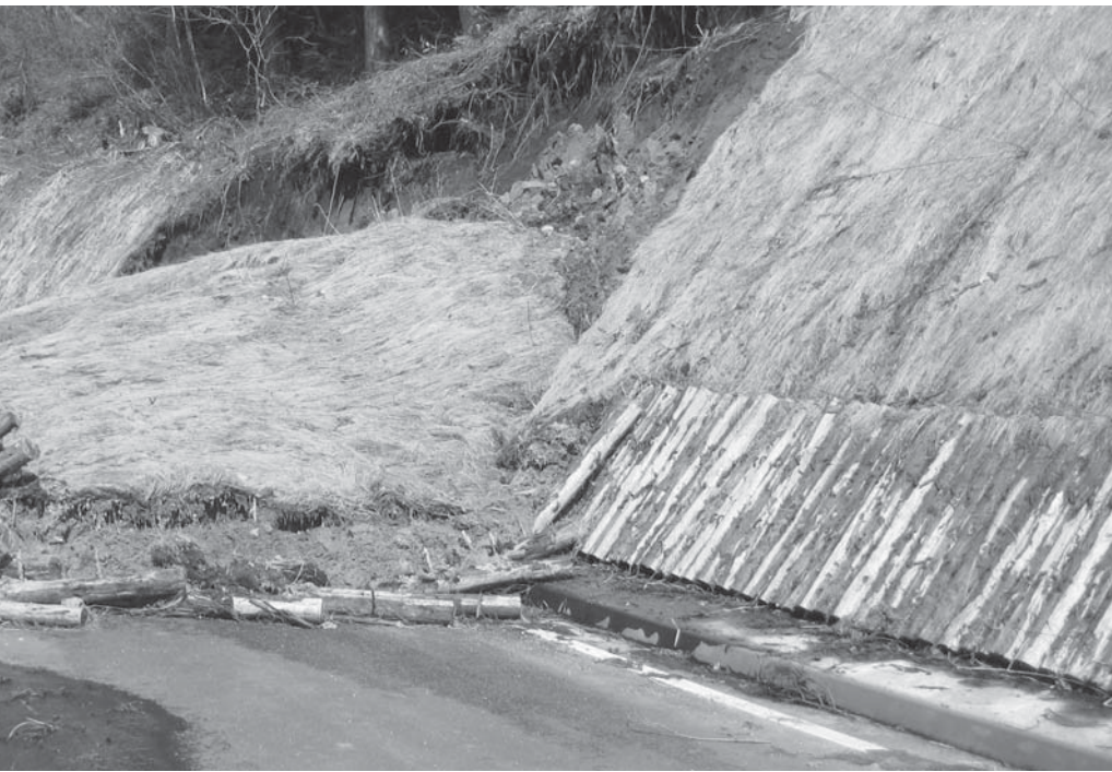
▲住民の安全確保へ計画的な工事が求められる
