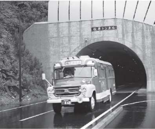
▲開通した桧原トンネル
