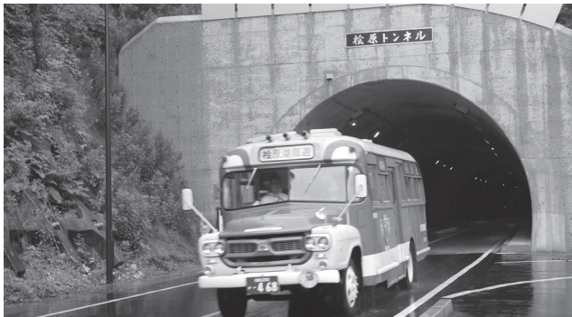
▶今年4月に開通した松原トンネル
