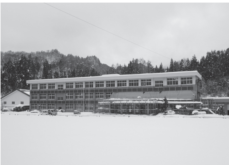
↑今年度、旧大塩小学校の工事完了に伴い、各公共施設の効果的な管理を。
