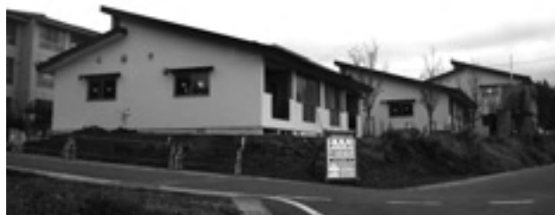
◀12月完成予定の村営住宅（3棟6戸）
