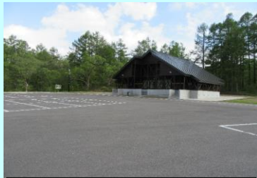
五色沼入口観光プラザ (拠点駐車場・広場・トイレ・休憩室)
