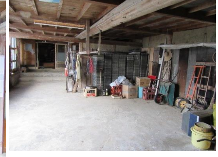
土間／玄関付近
