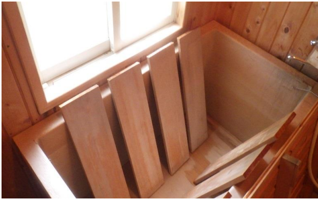
1 F 浴室 (浴槽)
