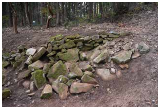
《4-11 虎口1 西壁の石積と崩れた石》
