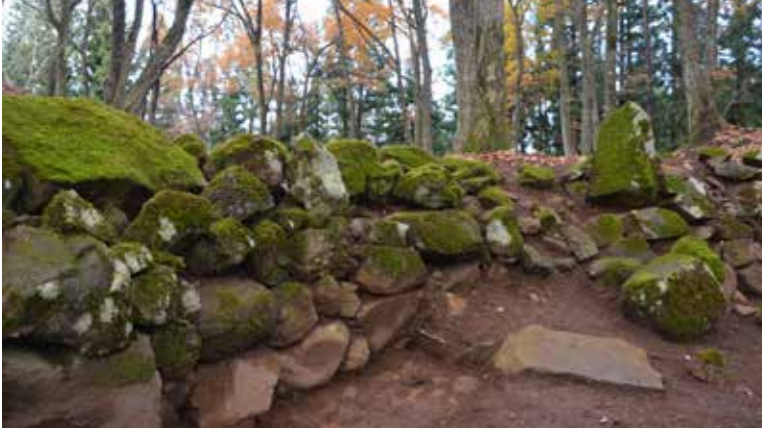
《武威を示す⑤》 主郭への玄関口となる虎口2付近に石を積み、階段状に積み、高さを出している。
