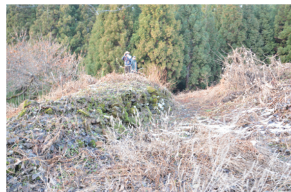
図3-49 石塁 南から 北側は高さのある石塁となる。石塁の西(左側)が曲輪5
