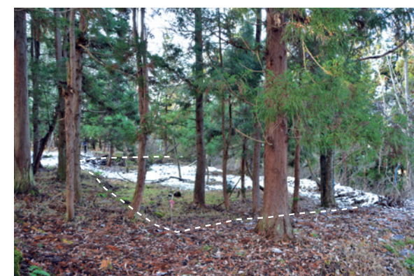
図3-7 曲輪A区画B 西から 手前と左側が通路。奥が区画A。通路の内側は掘り込まれて一段低くなっている。
