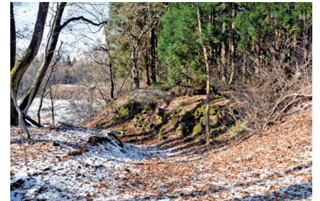
図3-26 虎口1 東から 周囲から一段低く掘り込まれる。石積みを施した枡形虎口である。
