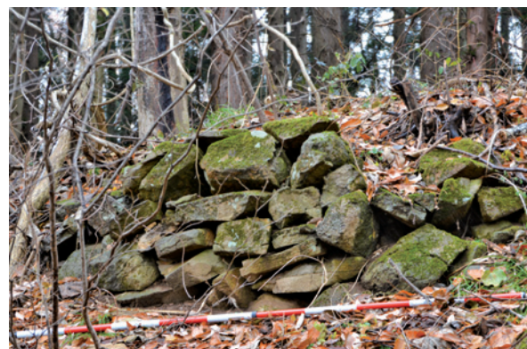
図3-23 虎口1北側の石積み 南から 現状で7段程度の石積みが確認できる。正面を横方向に長い面を向ける。
